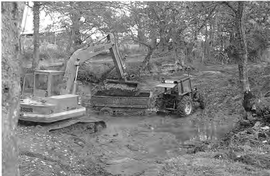
Curage d'une mare dans la réserve de Bois-Joubert.
