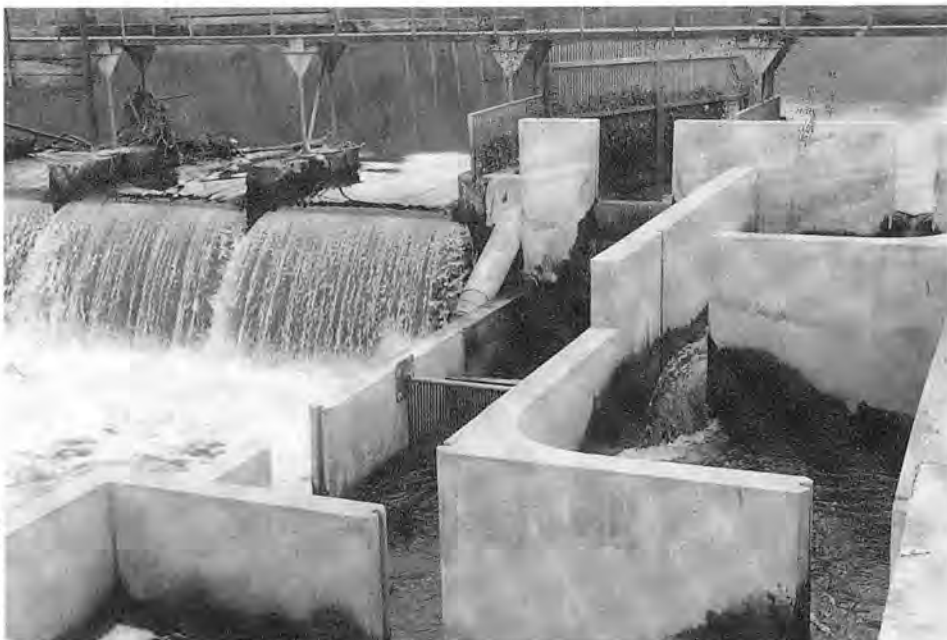
Passe à saumons sur le canal du Blavet.
