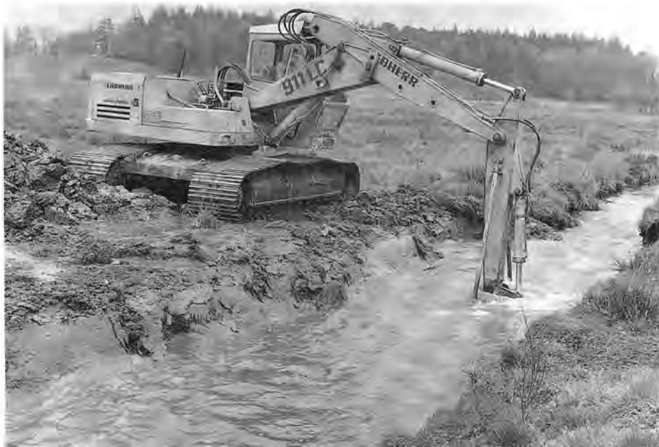
Rectification de ruisseau à la pelleuse
