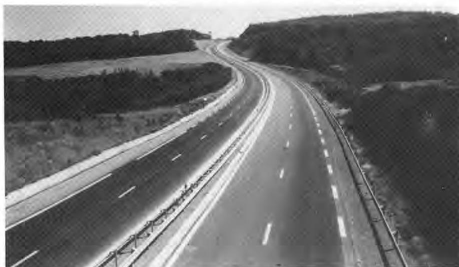
La saignée des routes à quatre voies, la RN 24 dans la traversée de la vallée de l'Evel, à Baud.
