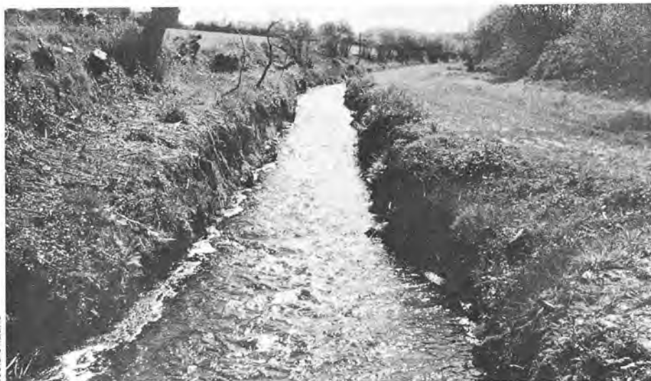
Le cours artificiel de la rivière de Pont-l'Hôpital modifie le site primitif.
