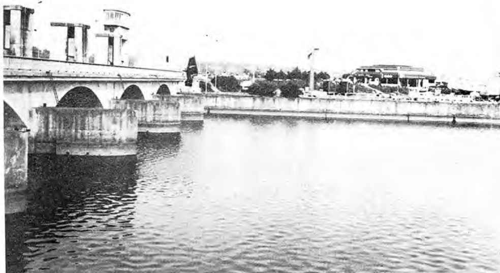
Photo 2. — Le pertuis et l'entrée des vannes. Le pont routier est levé. Au fond, à droite, le terre-plein portuaire et commercial.
