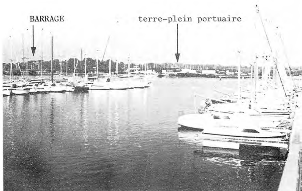
Photo 4. — Le port de plaisance, sur la rive gauche, immédiatement en amont du barrage.
