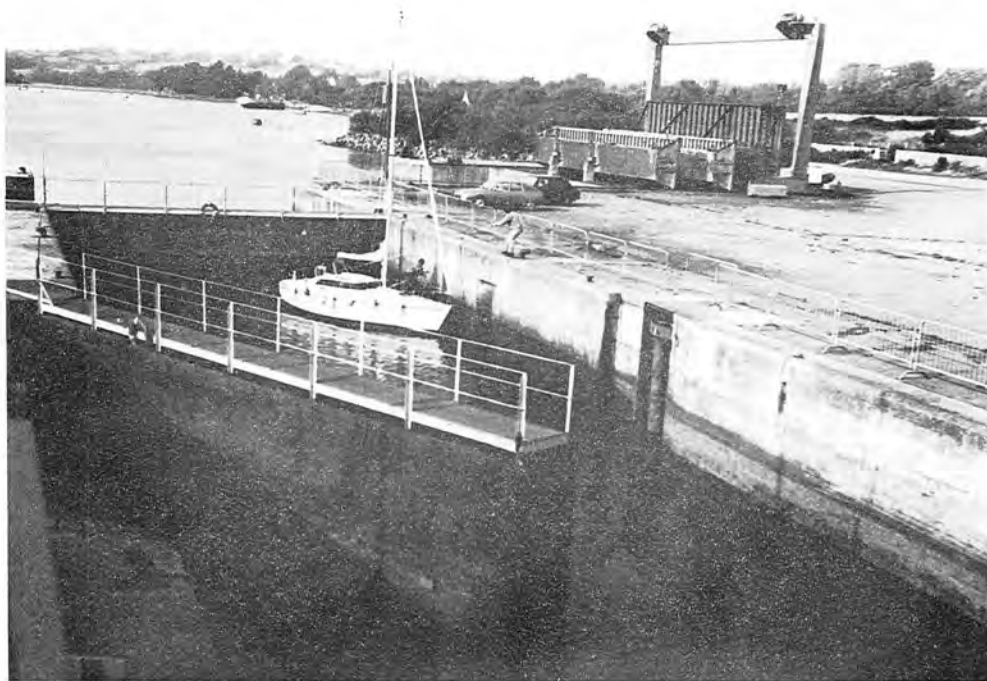
Photo 3. — Manœuvre de la porte intermédiaire du petit sas de l'écluse.
