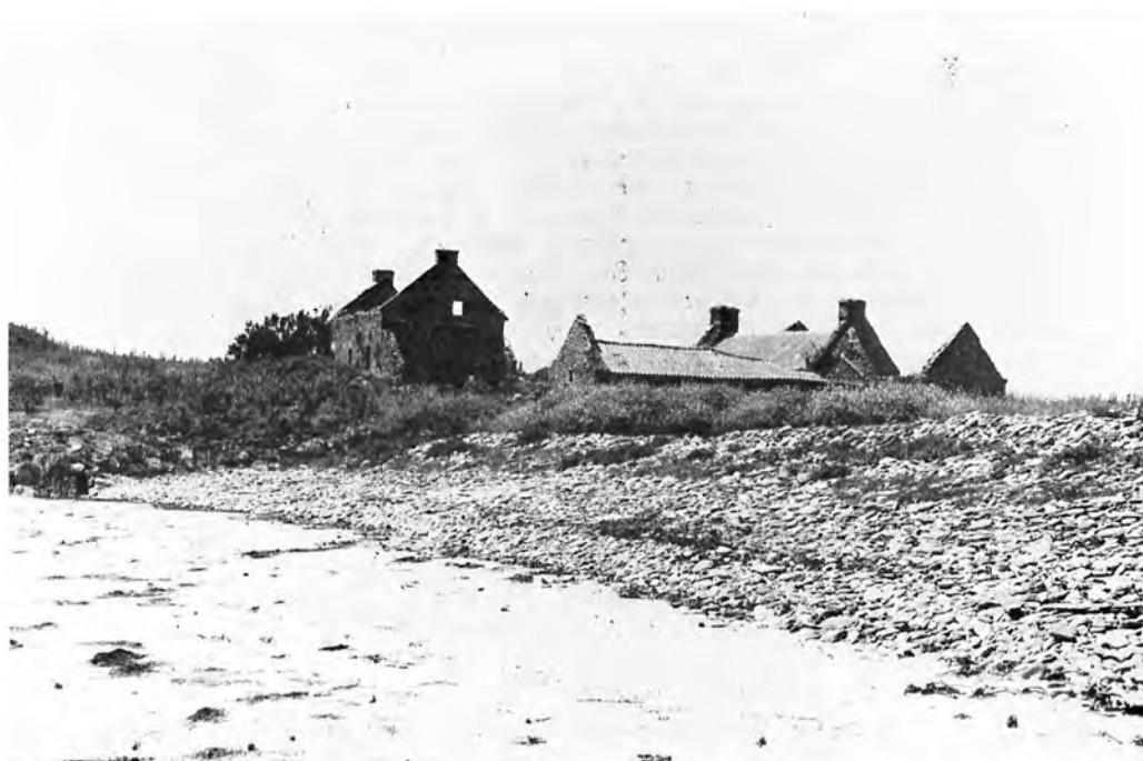
Bâtiments de ferme en ruine à Trielen.
