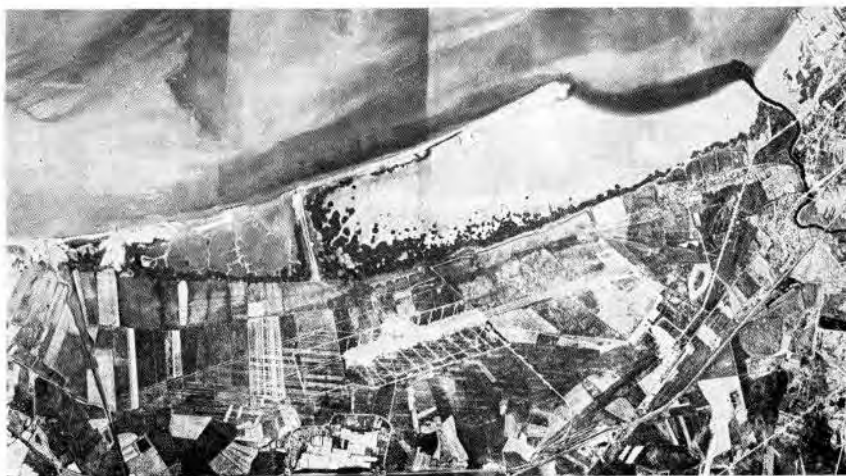
Photo 2. — Vue aérienne de la zone de Montoir dans les années 1950
