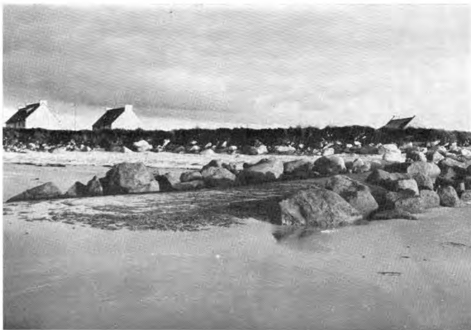
Cordon d'enrochement formé de boules de granite prélevées dans la partie inférieure de l'estran, devant la dune de Saint-Egarec en Kerlouan.
