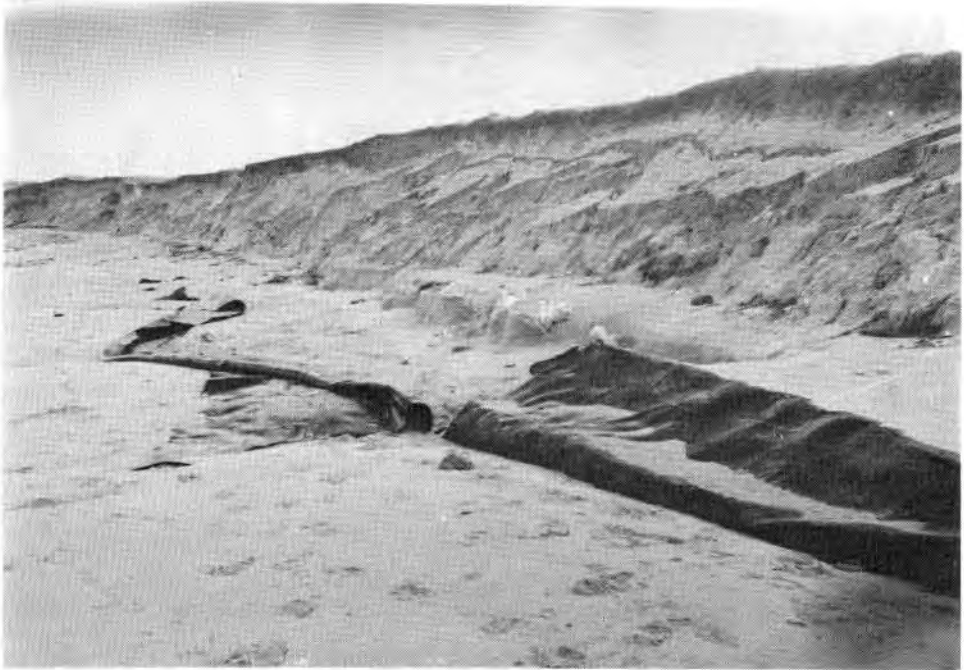
Barrage souple en voie de destruction devant la falaise de la dune du Curnic en Guissény.
