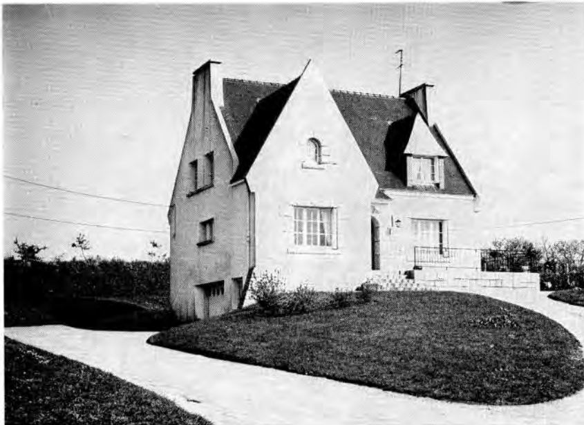
Saint-Renan — Discontinuité du bâti et isolement en centre de parcelle. Maison dite « néo bretonne » : potheis, capucine, arc en plein cintre, parement de pierre collée en chambranle.
