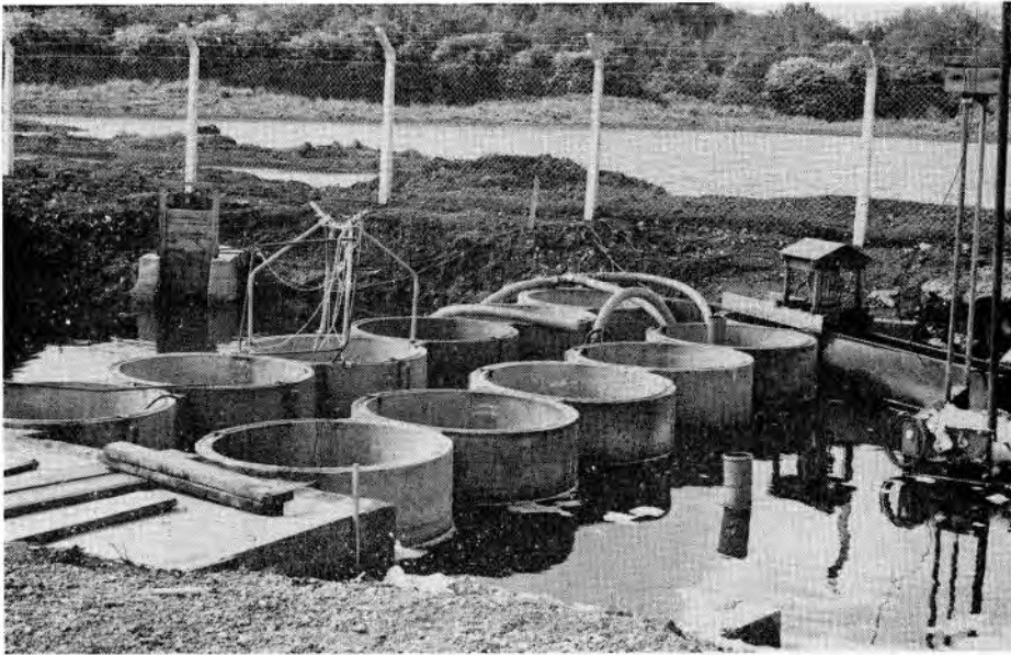
Aménagement en nurserie de la lagune de Faversham (Kent) sur la Tamise. Au premier plan, le bassin d'élevage, dans lequel baignent les bacs circulaires à naissain, où l'eau circule de bas en haut. A l'arrière plan, la lagune, dont l'eau, riche en plancton, est constamment pompée et déversée dans le bassin d'élevage.
