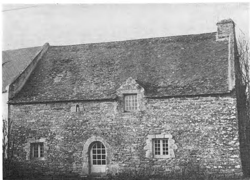
Fig. 2. — Sarzeau. Kerignard. Maison (1842) en gneiss, avec encadrements des baies en granite.
