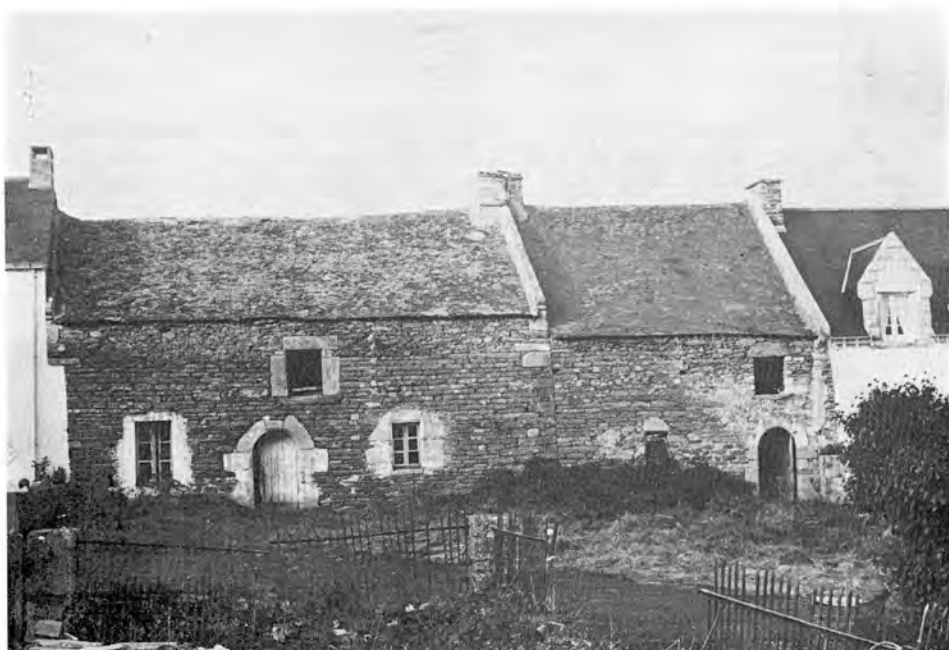
Fig. 3. — Sarzeau. Trevenaste. Exemple de maisons dont le mur de façade a été surhaussé pour changement de matériau de couverture.
