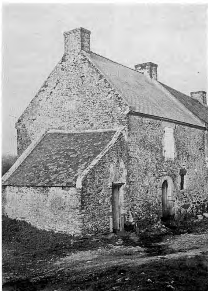
fig. 5. — Sarzeau. Kerignard. Dépendance en appenti au pignon d'une maison traditionnelle.
