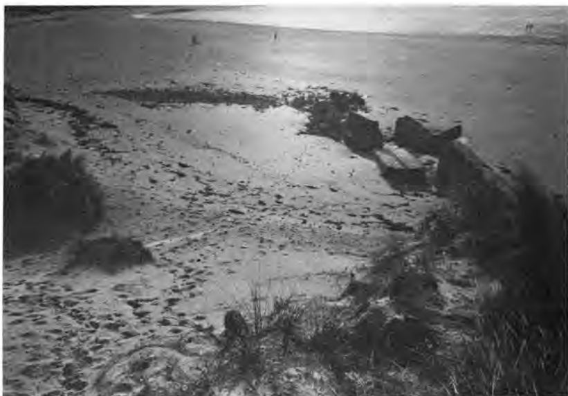
Les vestiges du mur construit par les Allemands à la pointe de Garreg Nevez montrent la position du littoral il y a 30 ans.
