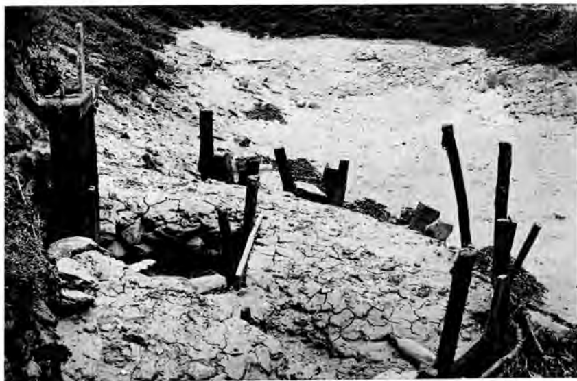
Cuve et trappe d'une vasière ; le batardeau de vase compactée délimitant la cuve, est traditionnellement renforcé par un claiage de bois.
