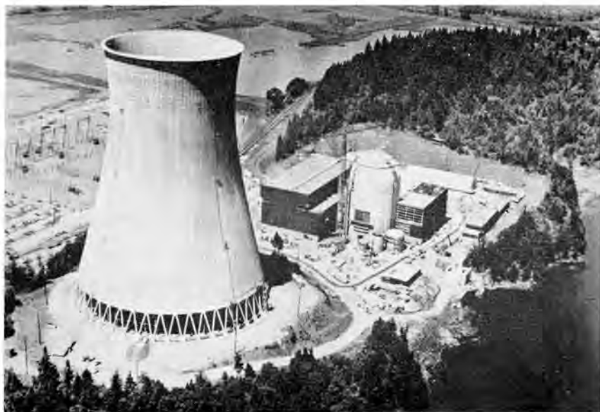
Tour de réfrigération humide (en circuit ouvert) d'une centrale nucléaire P.W.R. de 1200 MWe. en construction à Portland, Orégon (U.S.A.).
