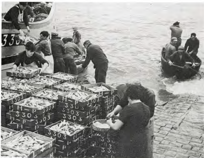
Fig. 3. — Mise à terre des sardines (La Turballe)
