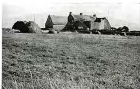
Les imbrications de volumes des annexes dans un petit groupement d'unités domestiques « Kerbréan »
