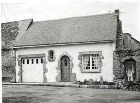
Les restaurations maladroites
