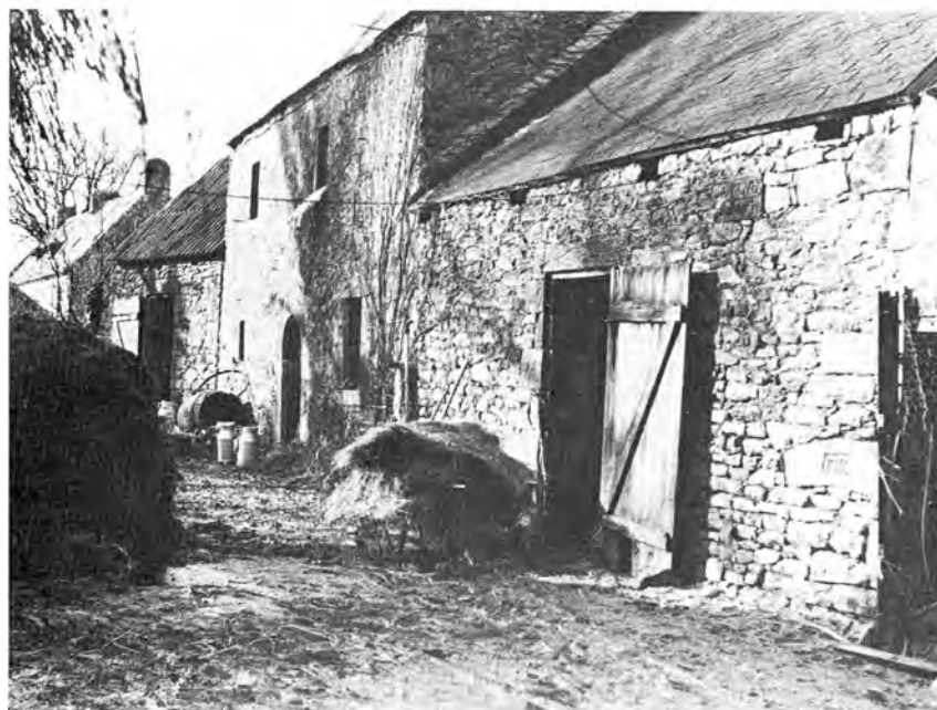
Fig. 5. — Sainte-Marguerite en Logonna-Daoulas. Bâtiment de ferme du 18 e siècle construit en microdiorite quartzique. Seule la pierre portant la date de construction est en kersantite.
