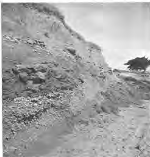
Fig. 7. — Erosion de la falaise à l'arrière du terre-plein : mise en relief des brèches et des parties concrétionnées des sables rouges (fin mai 1973).
