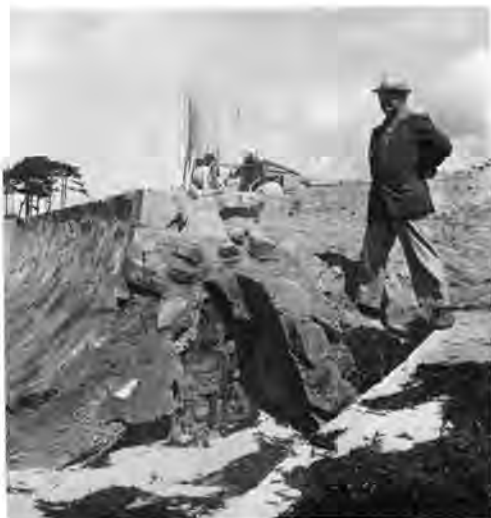
Fig. 2. — Le mur en cours d'achèvement : remplissage de vase durcie entre les deux parements.
