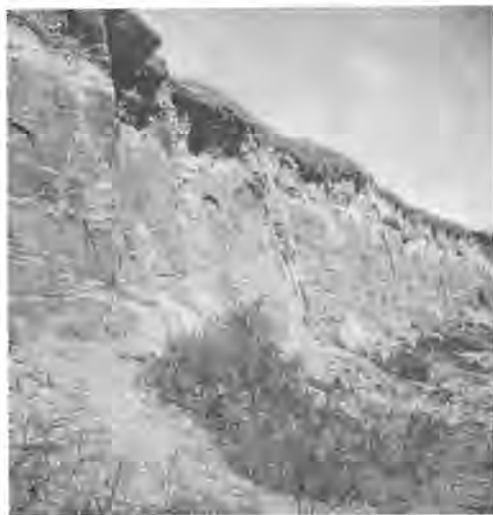
Fig. 6. — Erosion de la falaise meuble au Caillou Blanc : mise en corniche du head et en relief des fentes en coin dans les sables rouges. Petits éboulis frais de sable au bas. Végétation sur le head éboulé (fin mai 1973).
