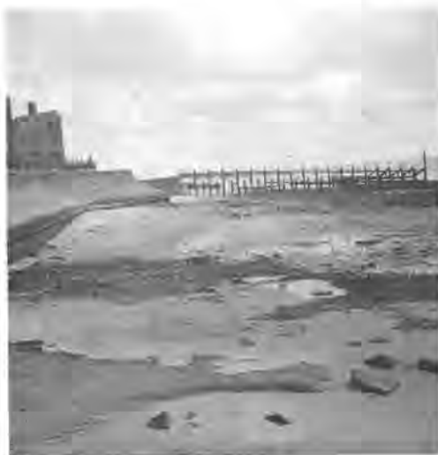
Fig. 3. — Déchaussement des palplanches de la base du mur à l'emplacement de l'ancien cours du Pontereau. Vase durcie au premier plan, dans la vase molle ; formation alluviale noire au second plan ; cartraie. Notez le délabrement des épis réduits à leurs pieux verticaux (fin mai 1973).
