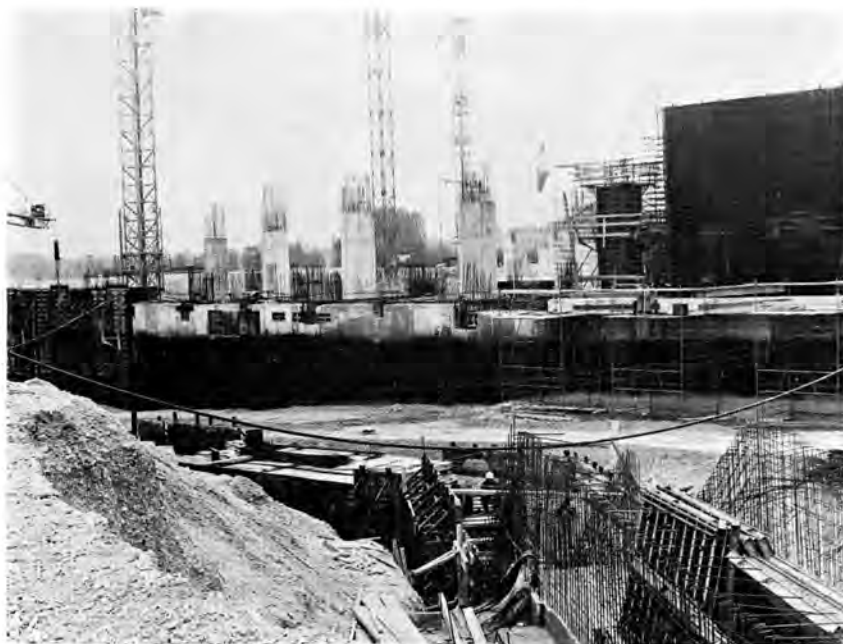
Le chantier de la centrale Bugey II (filiale P.W.R.)
