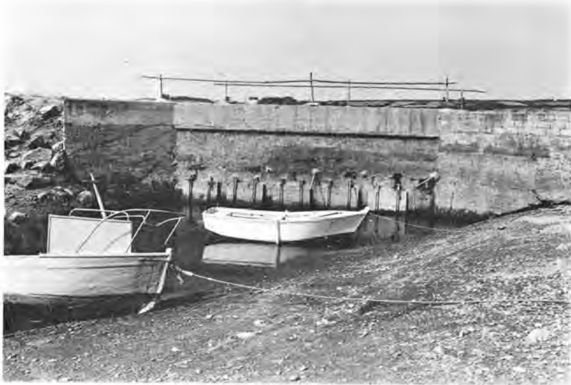
L'Aber : la digue
