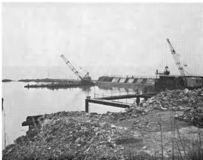
Fig. 5. — La partie orientale du nouveau port à marée basse de coefficient 117, le 27 février 1971 à 12 h. 30. On aperçoit le « ballast », les prismes (ou « plots ») de béton, la « palissade » métallique qui les surmonte actuellement et, au premier plan, l'amorce du terre-plein nord.
