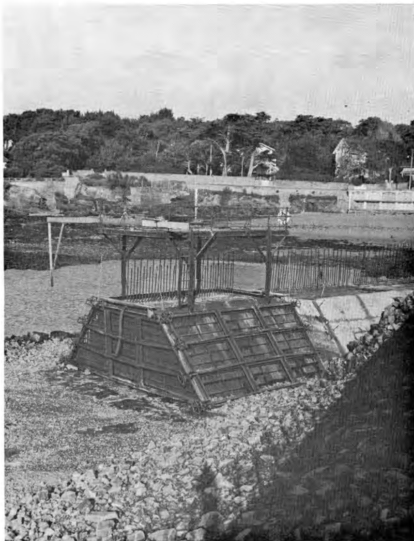
Fig. 2. — Au premier plan, le « ballast » de blocs de leptynite et le coffrage en forme de prisme ; à droite de celui-ci, le soubassement trapézoïdal décoffré ; « palissade » de tiges d'acier. Au second plan, l'estran rocheux et l'extrémité ouest de la plage de la Noëveillard. Au troisième plan, les parcs des villas (février 1971).
