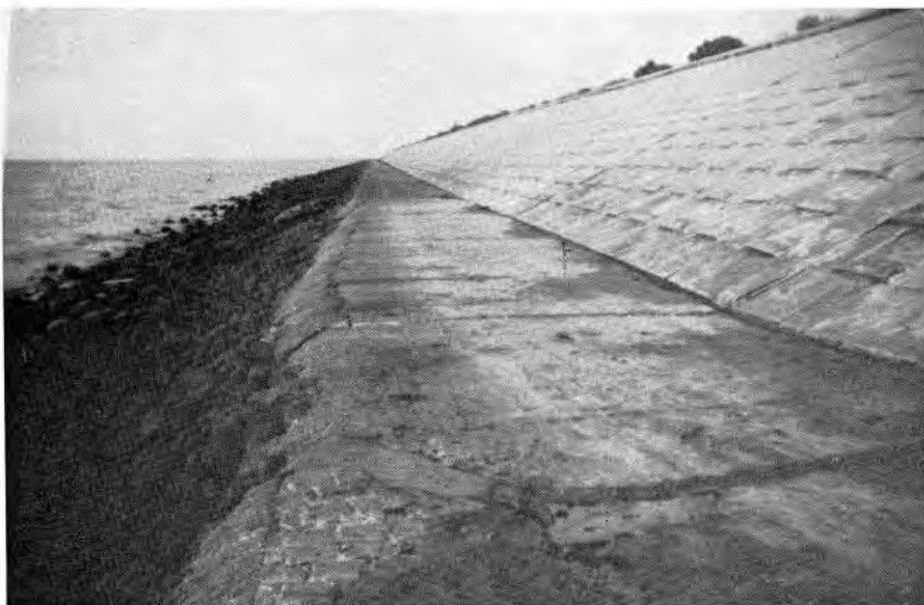
Fig. 3. — La digue rénovée des Champs à La Louippe. Revêtement de dalles de béton. Au pied du trottoir de l'ancienne digue, blocs de calcaire éocène formant « enrochement » de protection.
