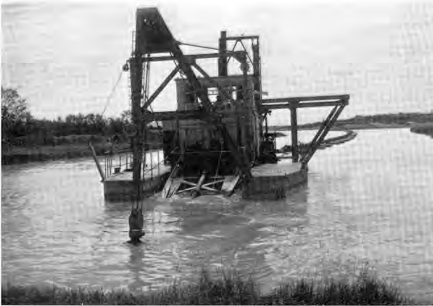
Photo 3. — La drague flotte sur le lac artificiel créé par l'extraction des alluvions stannifères de Saint-Renan. La tête suceuse de la drague, immergée, aspire les alluvions recouvertes par la végétation herbacée visible au premier plan. Le train de tuyaux convoie les alluvions jusqu'à l'installation de débouage visible au fond à droite.
