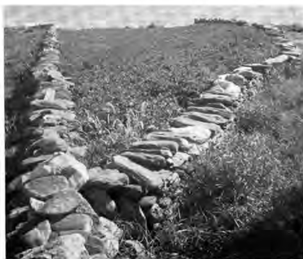
Fig. 3. — Muretins en pierres sèches en bordure de mer, dans le Sud-Finistère
