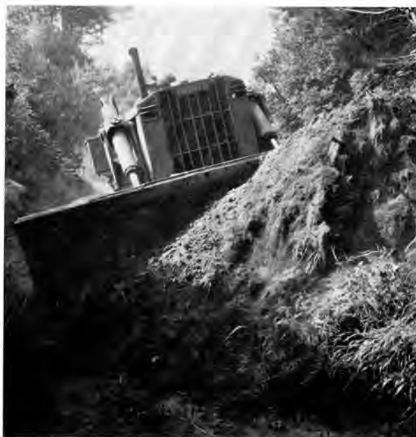
Fig. 2. — Un bulldozer en action
