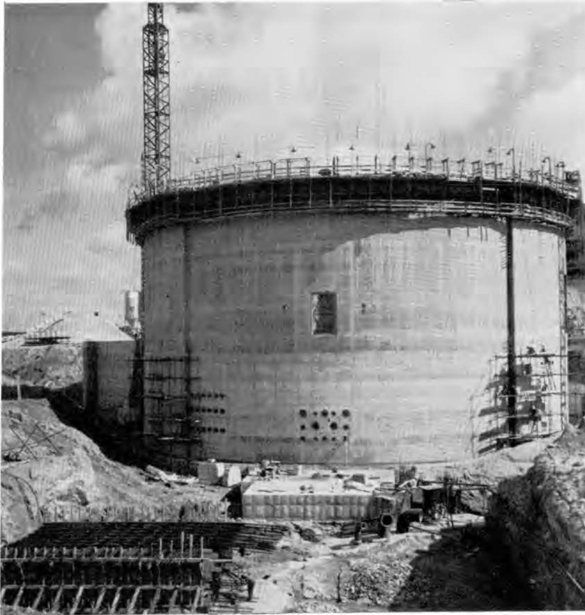
Fig. 1. — Construction du bâtiment du réacteur au 1 er juin 1963
