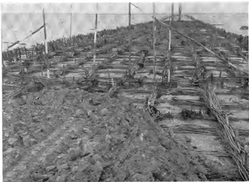
FIG. 2. — Les fascinages de la nouvelle digue
