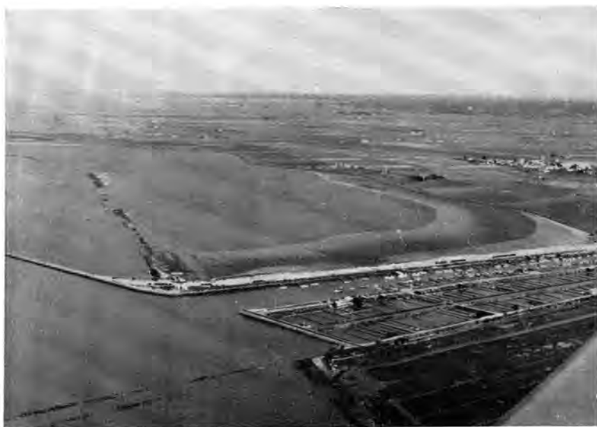
FIG. 3. — Photographie aérienne du Bec de l'Epoids. On distingue de gauche à droite : la nouvelle digue, la digue ruinée du polder du Dain, la digue interne de ce polder, le village de l'Epoids. Au premier plan, le port du Bec et ses bassins ostréicoles.
