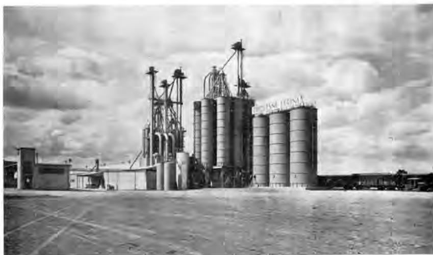
Fig. 3. — L'usine Duquesne-Purina et l'embranchement de la voie ferrée (Photo Aubert - Loudéac)
