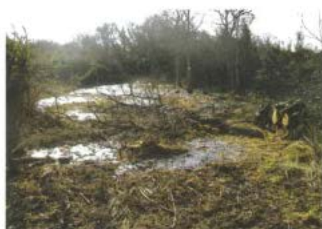
Ouverture du pare-feu.
