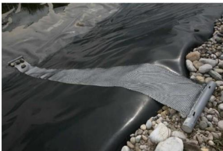
Photo 2 : Échappatoire à faune dans un bassin à incendie
