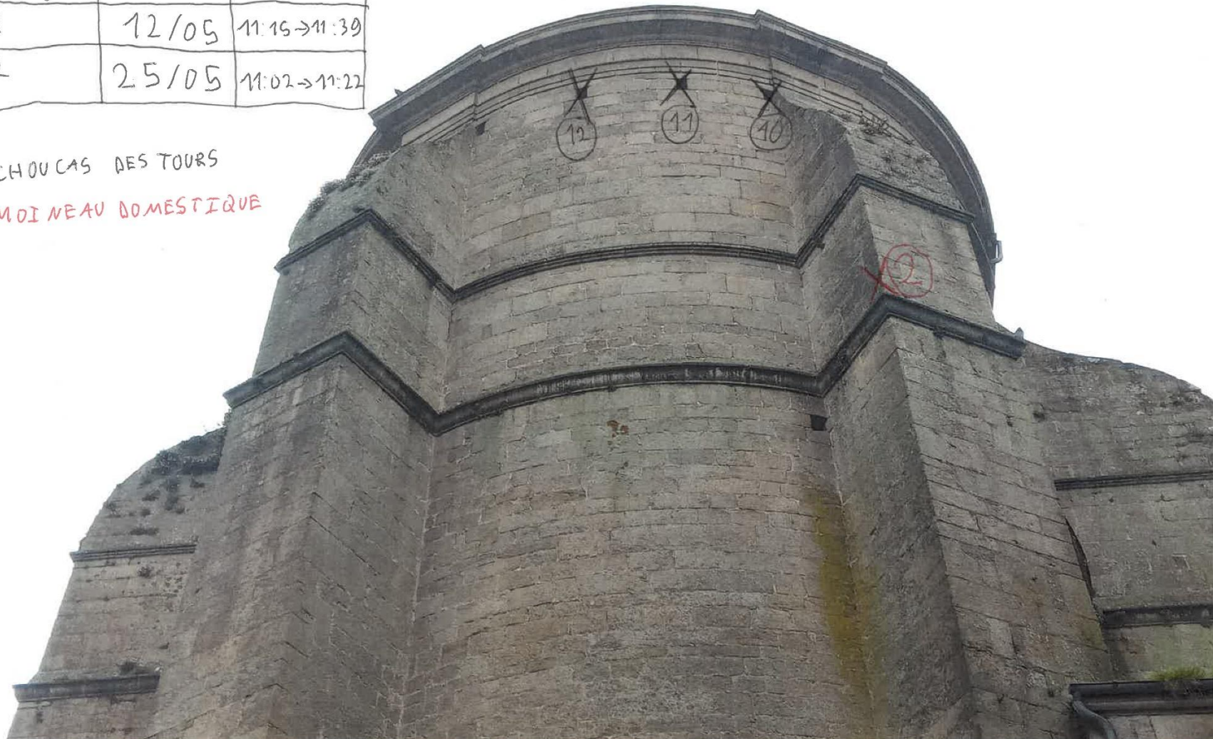
Figure 4 : façade est de la chapelle de l'auditorium et localisation des cavités et anfractuosités occupées par l'avifaune nicheuse. Photographie : T. Guilbot de Neville. Page 10 sur 19
