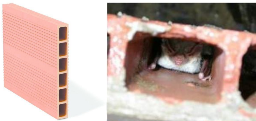
Figure 13 : Brique creuses favorable à l'accueil des chiroptères
