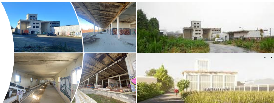
Photo 1 : Présentation du site avant et futur projet de réhabilitation
