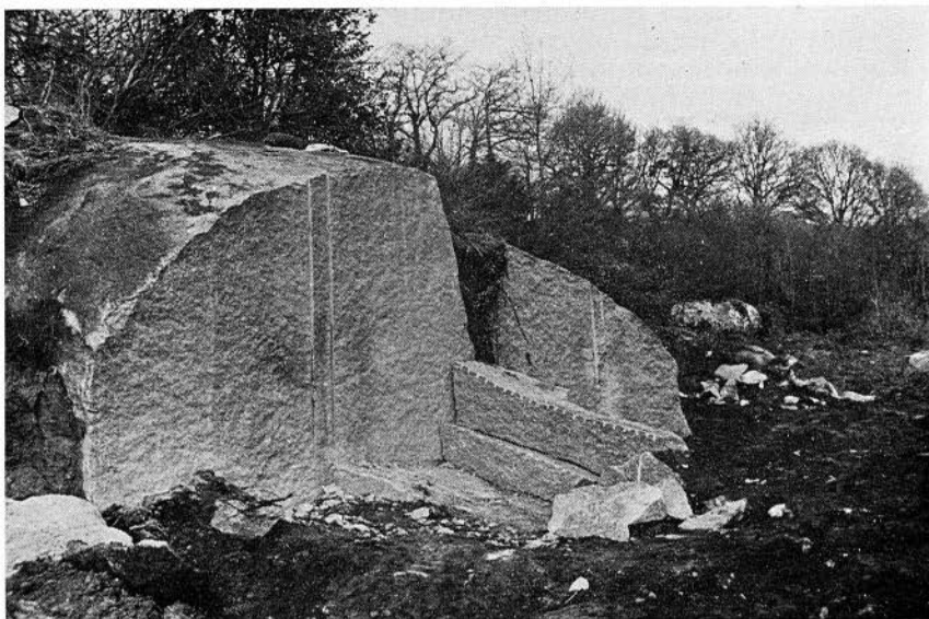
Débitage d'une boule de granite du Huelgoat, à droite de la route Huelgoat-La Feuillée.
