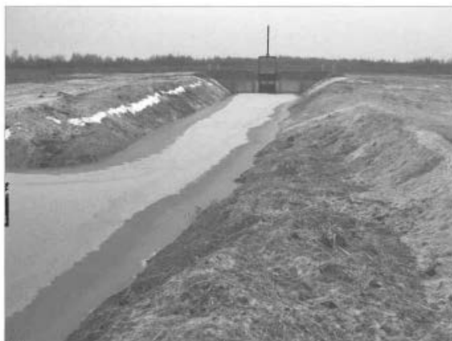
Écluse aménagée sur le canal Paviedskyt.
