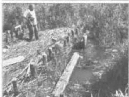
Retenues aménagées sur le canal près de Viunauka (haut) et sur la rivière Narau (bas).
