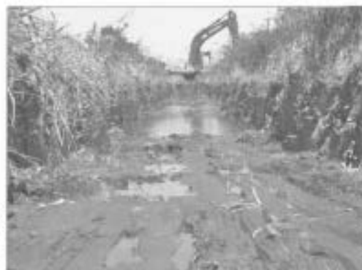
[8] Gauche : creusement d'un fossé périphérique à Pen Mané.
