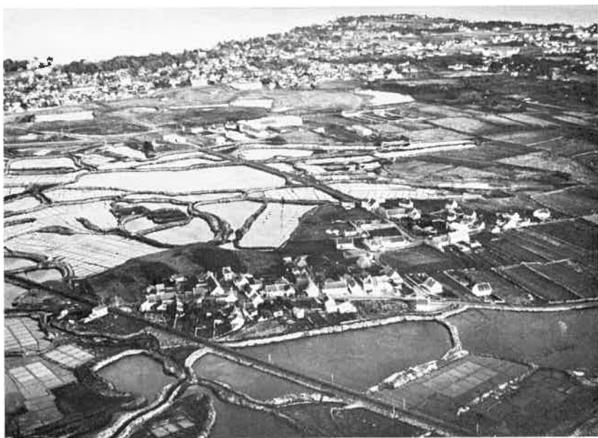
Le comblement des marais continué pour permettre l'extension de la construction.
