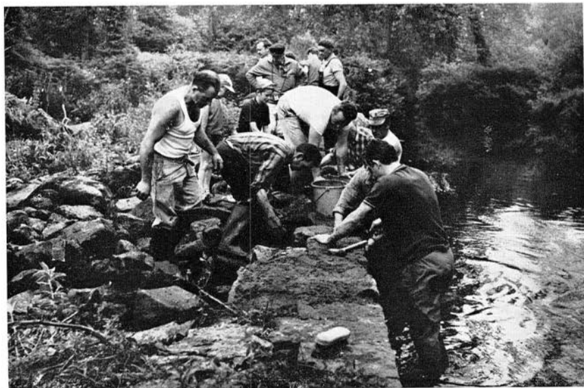
Fig. 1. — Réfection du bief de Kapékern sur le Léguer en juillet 1968, par un groupe de pêcheurs bénévoles.
