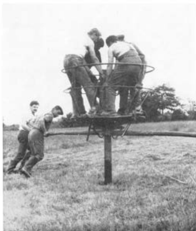
Fig. 39. — Exploration des alluvions à la sondeuse Banka.
