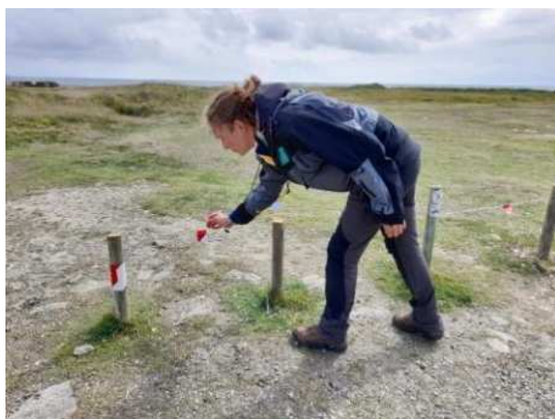
Photo 53 : Installation du câble sur le parking de la Pointe des Chats, © RNN Groix, 2021.
