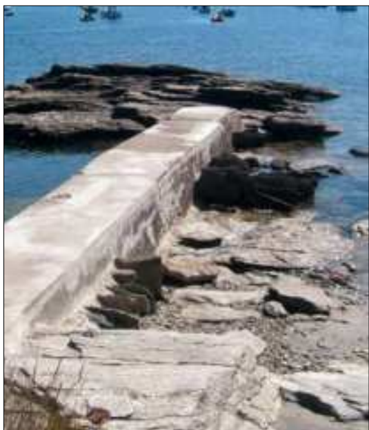
[7] Les dalles de « Perzigou » en réemploi dans la vieille cale de Kersauze, à Locmaria
