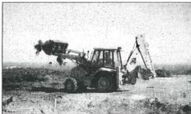
Les travaux du parking de la réserve du Cap-Sizun ont débuté.
