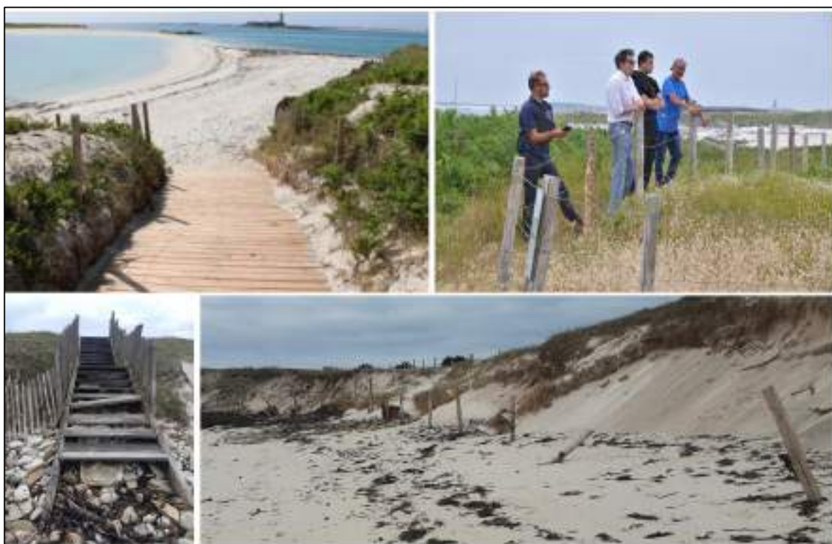
Photo : Réfection de l'accès au tombolo, présentation de la clôture de la réserve intégrale, dégradation après les tempêtes hivernales de l'escalier de la plage nord et de la clôture bords de la plage est © Bretagne Vivante-CCPF.
