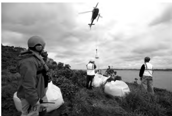
Dépose par hélicoptère des matériaux pour le chantier de l'île aux Dames
