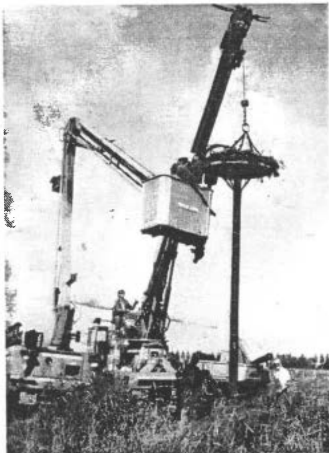
L'édification d'une plate-forme.
