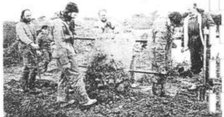
« L'art de construire le talus comme il y a 100 ans ».
