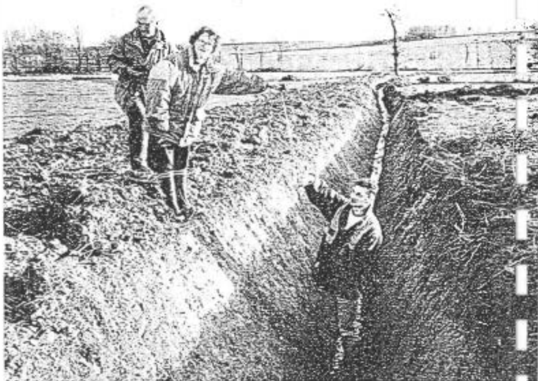
Les écologistes et naturalistes déplorent la transformation des ruisseaux en fossés d'hydraulique aux abords du Meu sur la commune de Muel en fin de remembrement.
