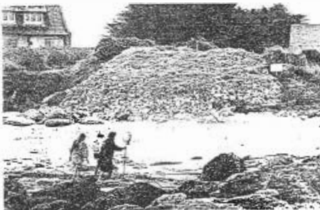
L'« enrochement » du préfet des Deux-Sèvres qui crée l'embarras à Santec.
