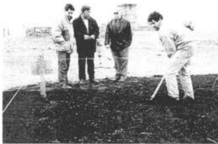
Sous l'œil intéressé du maire de Plogoff et des techniciens de l'Équipement et de la SEPNEB, la mise en place d'une végétation broyée qui doit repousser toute seule.
