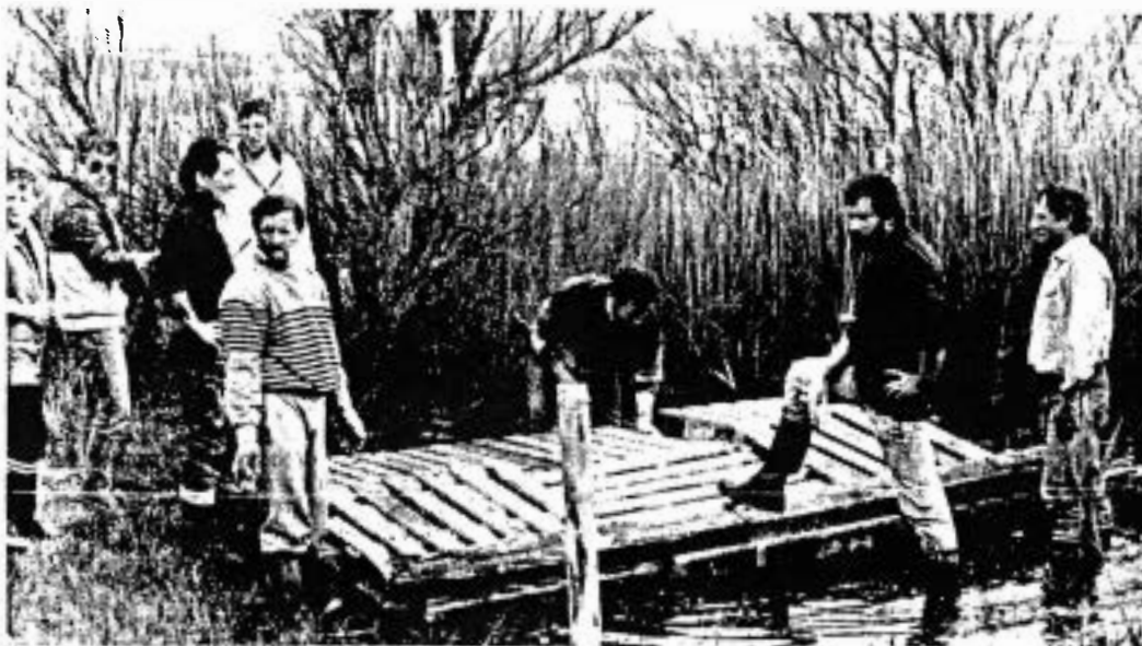
La mise à l'eau du reposoir à cormorans
