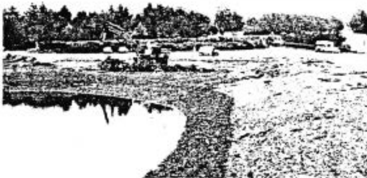
Le site du Bendy reprendra son aspect d'origine. Du déblaiement, on ne laissera que les galets sur la grève.
