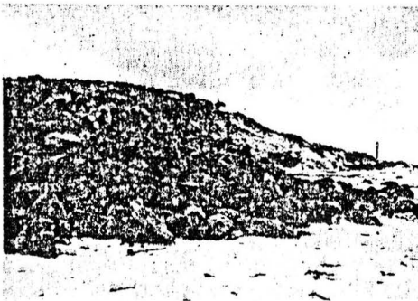
TRÉFLEZ. — Le rempart s'écroule progressivement.
