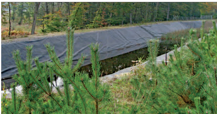
Bassin de décantation de l'autoroute A84
